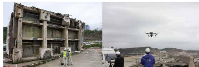
据置型レーザースキャナ 女川町江島共済会館ビル
