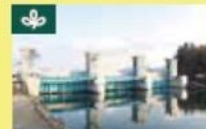
水尻川防潮水門
