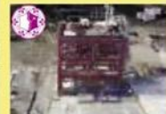
防災対策庁舎
